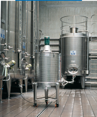
Пример заделки швов в винном производстве
