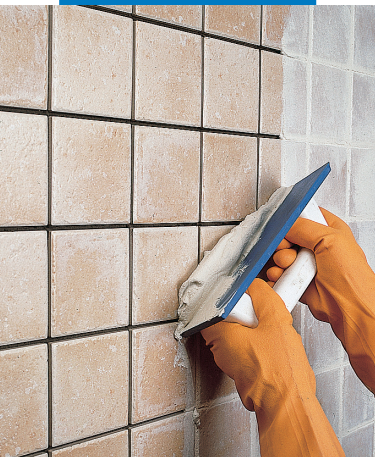
Заделка швов плитки одинарного обжига мастерком
