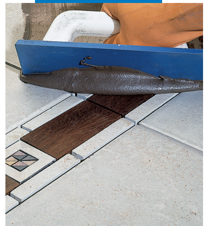
Заделка мастерком швов керамического пола с деревянной вставкой
