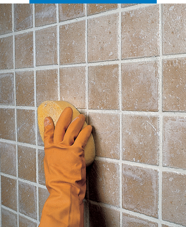
Отделка плитки одинарного обжига губкой
