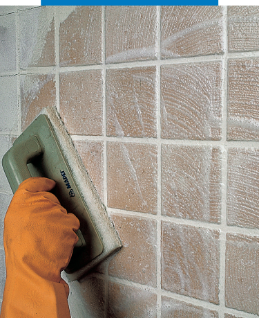
Отделка плитки одинарного обжига теркой Scotch-Brite R
