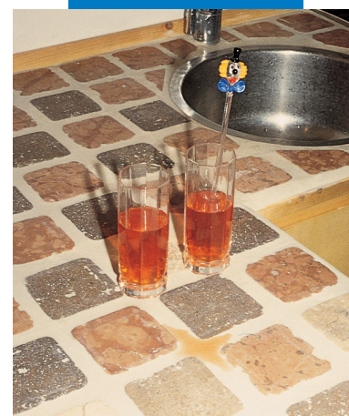
Пример приклеивания и заделки швов на кухонной стойке
